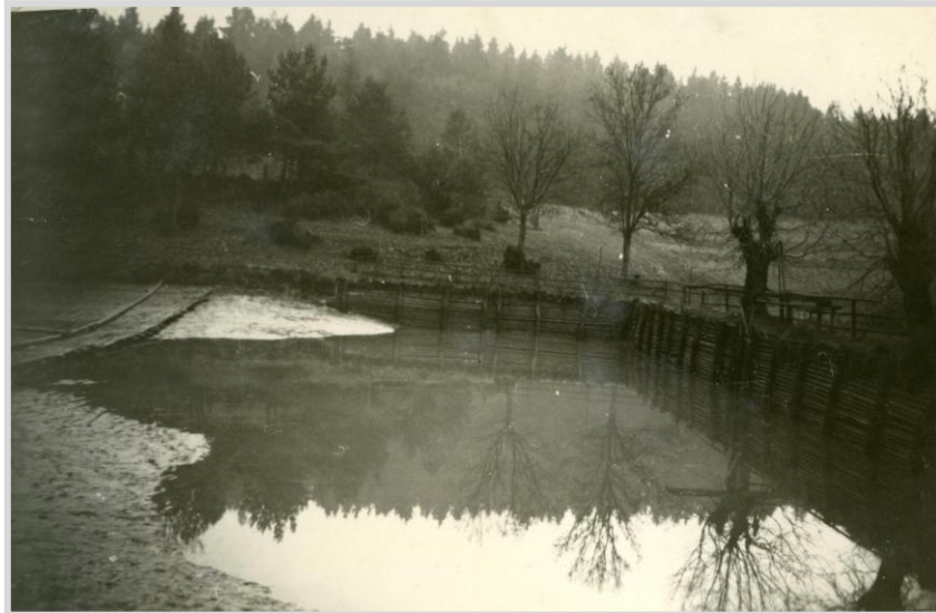
(Bild: VEO-Archiv, 20.04.1935 Holzabstützung)
