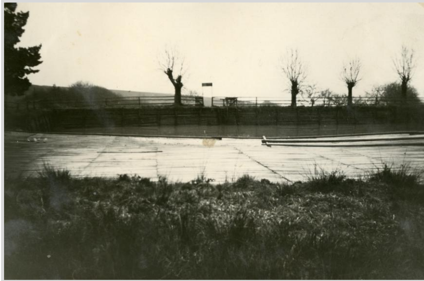
(Bild: VEO-Archiv, 20.04.1935 Holzboden)
