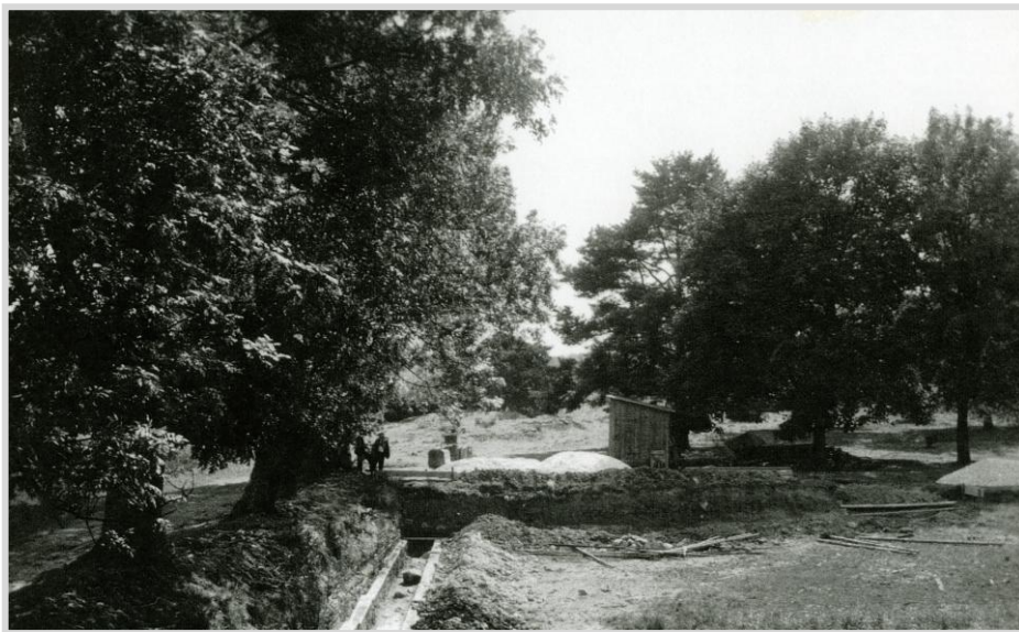
(Bild: VEO-Archiv, 1956 neue Fundamente werden eingebracht)
