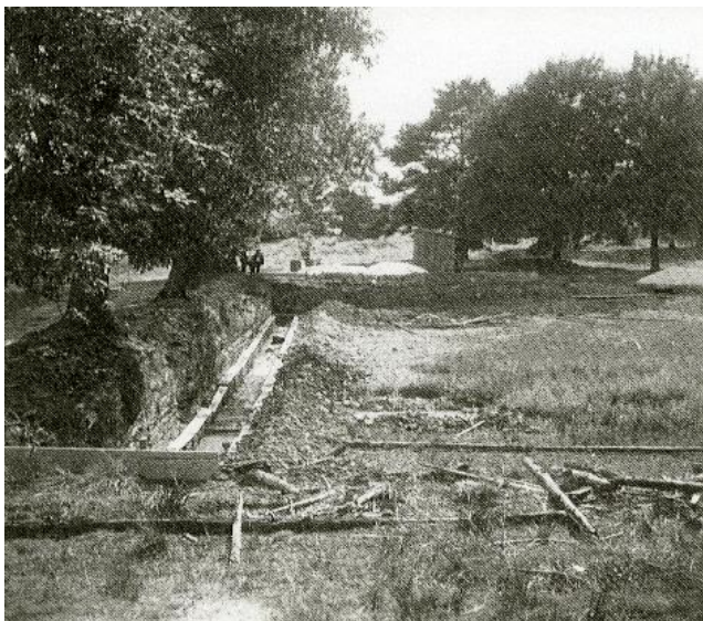
1948, der Unterwasserholzboden schwemmt auf
