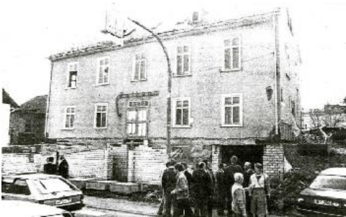
Pilotprojekt "Alte Schule" Im April 1987 wurden die Sanierungsmaßnahmen an der "Alten Schule" fertiggestellt. Die Umbaukosten bezifferte Bürgermeister Rolf Eggebrecht auf eine Million DM. Nun wird das Gebäude eine Arztpraxis, Arztwohnung und eine Sozialwohnung bieten.
