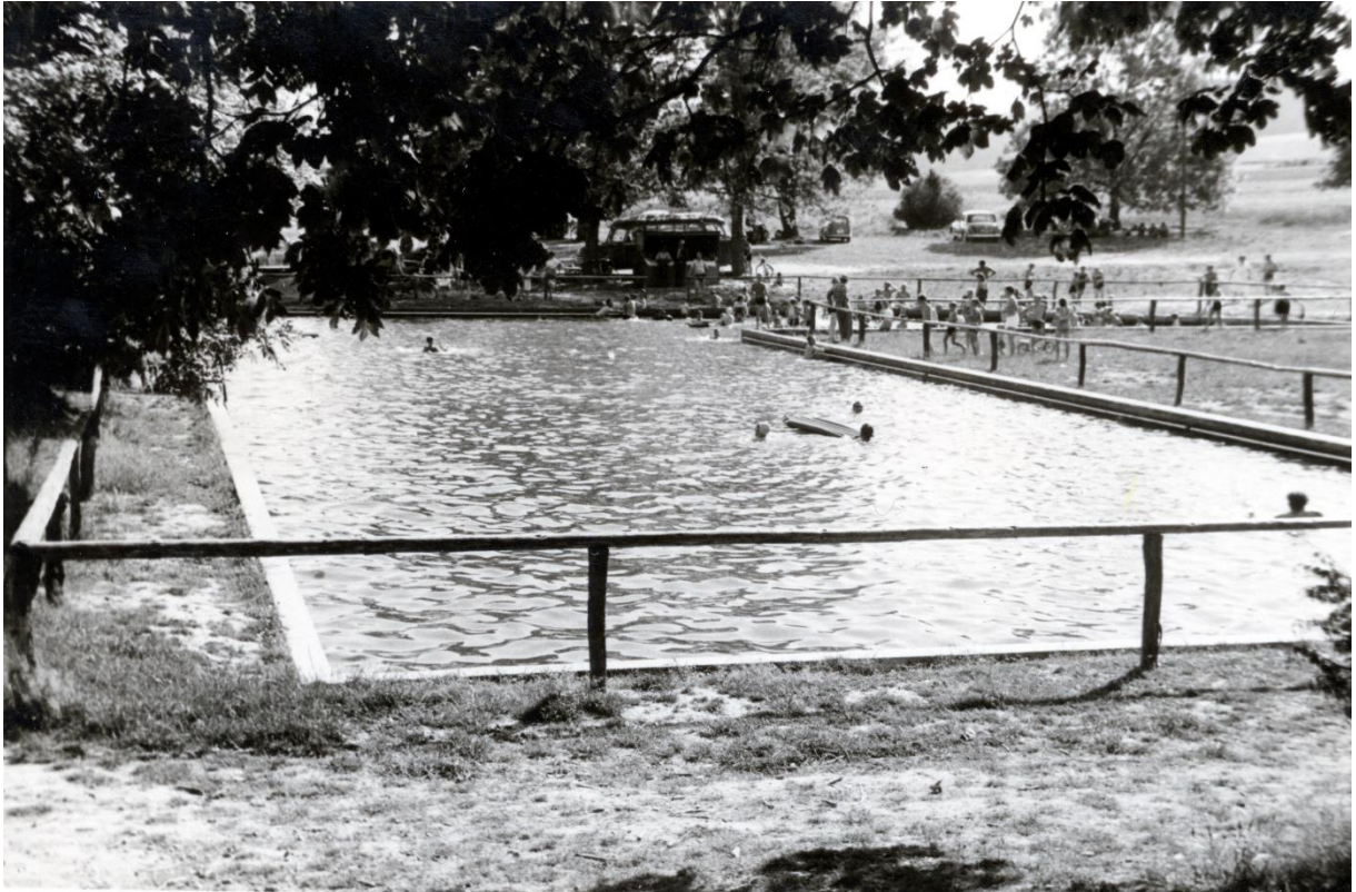
(1955 Das alte Schwimmbecken aus Holzpfählen wurde durch ein Betonbecken ersetzt)
