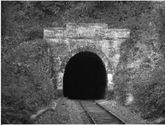
(Bild: VEO-Archiv, Hasselborner Tunnel)
